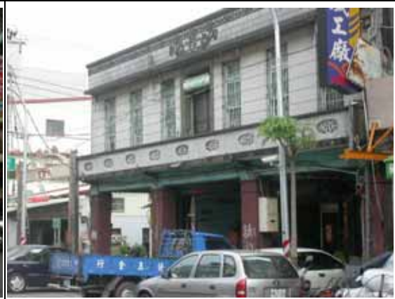
沿海一路仍存有許多日式店家建築
