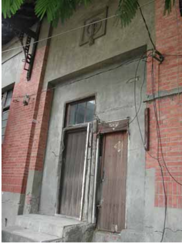
三處大門皆被拆除
