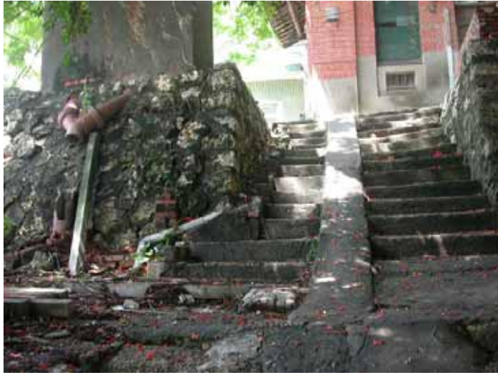
老咕石是武德殿周圍環境使用的主要材料
