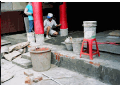
水泥台階施工中
