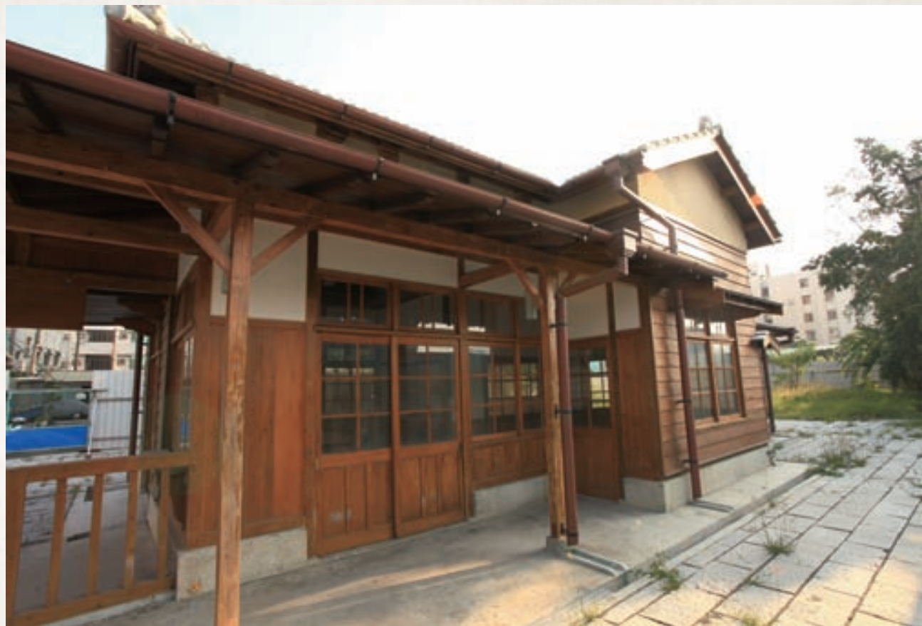
三塊厝車站修復工程雖已在2012年9月完工，看上去嶄新與過去破敗模樣完全不同，彷彿是不同個體。
