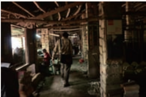
窯內暗黑，人影晃動，彷彿走在時光長廊一角。
