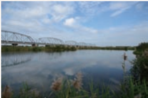
母親河上的高屏舊鐵橋。
