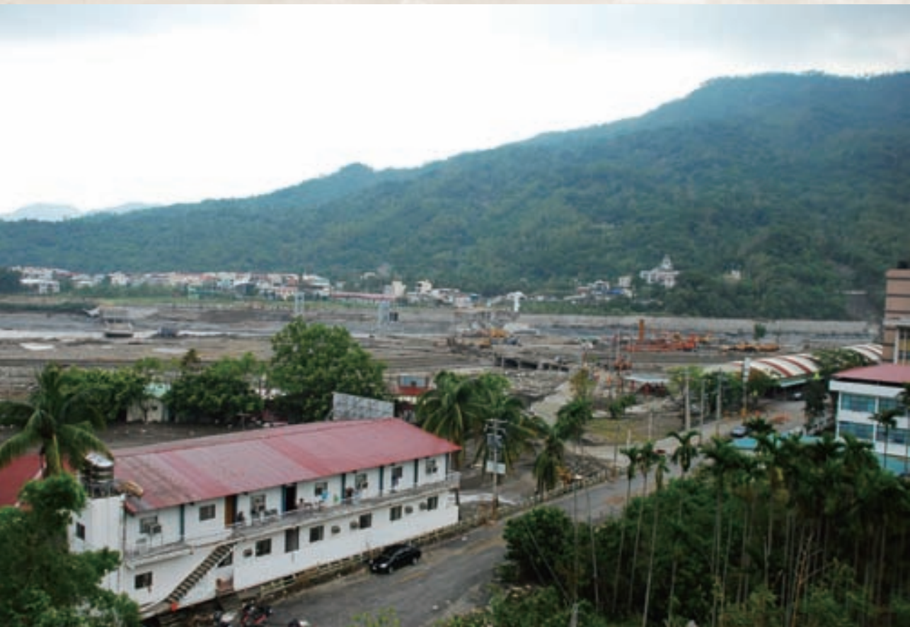
八八風災後甲仙區的搶救工程。
