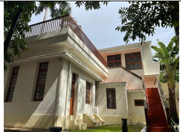
建物立面外觀（辦公廳北面）
