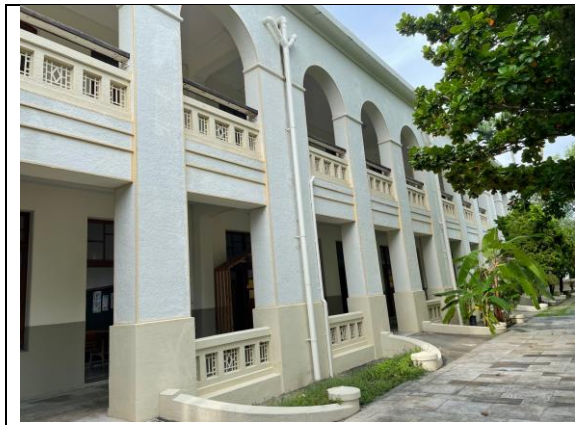
建物立面外觀（北棟教室南面）
