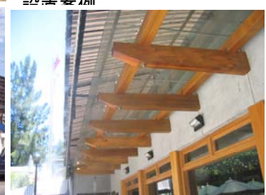
木構架結合玻璃設置雨庇
