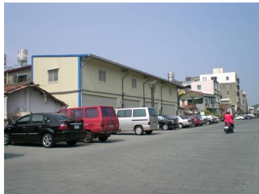
● 道路拓寬後搭建之鐵皮屋 ( 5 )
