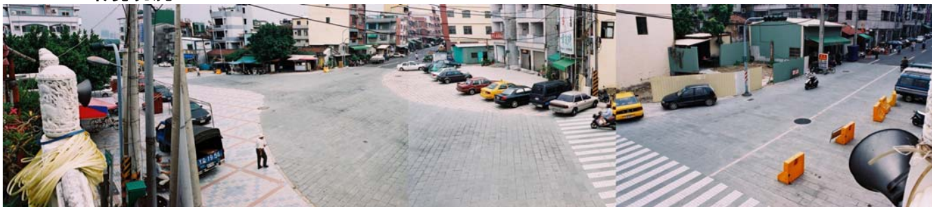
元帝廟前廟埕廣場與路口地坪現況
